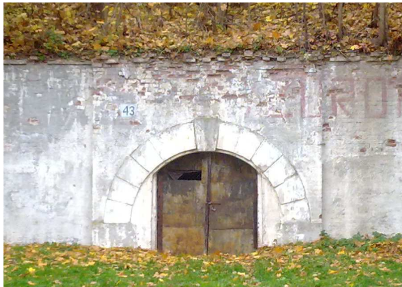
Widok na ryzalit budowli.
