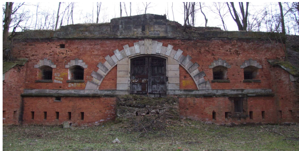
Widok na elewację północną.
