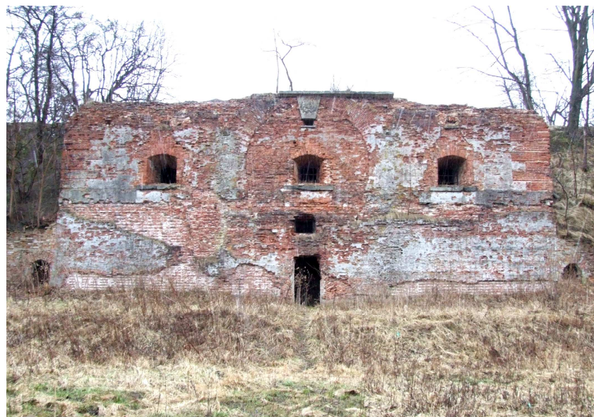
Widok na elewację północną.
