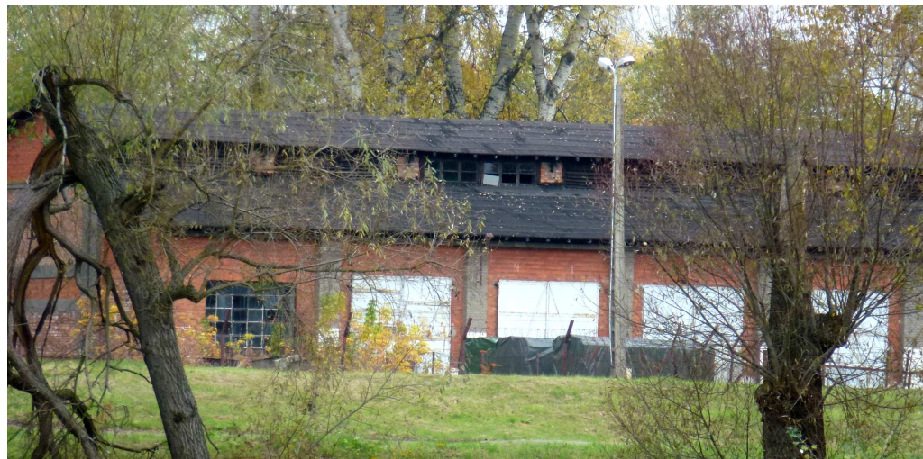
Widok od strony południowo-zachodniej
