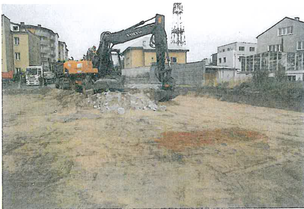
Fot. 17. Przebudowa ul. Warszawskiej oraz budowa i przebudowa ul. Modlińskiej na odcinku od ul. Paderewskiego do muru odgraniczającego teren zielony od parkingu przy budynku przy ul. Słowackiego 4 (dz. nr ew. 4/7 obr. 34-8-08) w 2015 r. Nadzór archeologiczny - kontrola prowadzonych prac ziemnych. Zachodnia część nadzorowanego odcinka.
