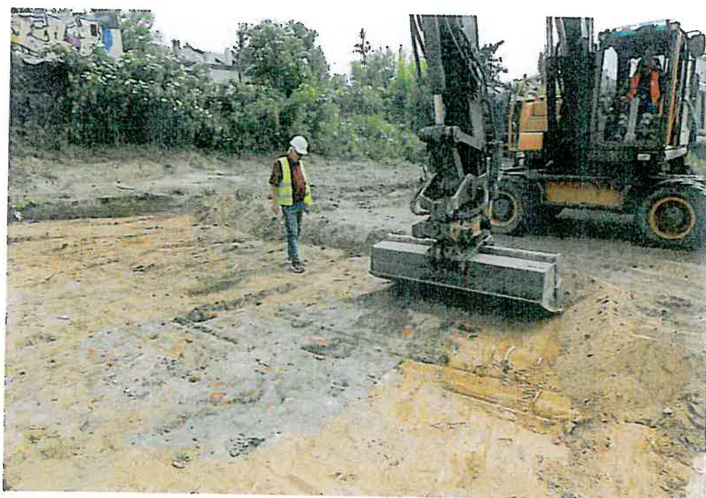
Fot. 3. Przebudowa ul. Warszawskiej oraz budowa i przebudowa ul. Modlińskiej na odcinku od ul. Paderewskiego do muru odgraniczającego teren zielony od parkingu przy budynku przy ul. Słowackiego 4 (dz. nr ew. 4/7 obr. 34-8-08) w 2015 r. Nadzór archeologiczny - kontrola prowadzonych prac ziemnych. Wschodnia część nadzorowanego odcinka.
