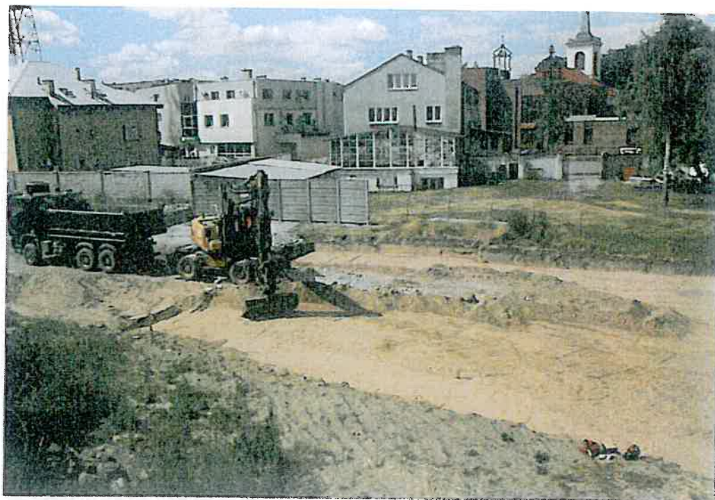
Fot. 15. Przebudowa ul. Warszawskiej oraz budowa i przebudowa ul. Modlińskiej na odcinku od ul. Paderewskiego do muru odgraniczającego teren zielony od parkingu przy budynku przy ul. Słowackiego 4 (dz. nr ew. 4/7 obr. 34-8-08) w 2015 r. Nadzór archeologiczny - kontrola prowadzonych prac ziemnych. Zachodnia część nadzorowanego odcinka.
