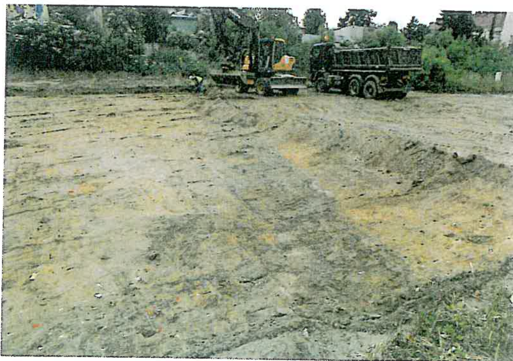
Fot. 8. Przebudowa ul. Warszawskiej oraz budowa i przebudowa ul. Modlińskiej na odcinku od ul. Paderewskiego do muru odgraniczającego teren zielony od parkingu przy budynku przy ul. Słowackiego 4 (dz. nr ew. 4/7 obr. 34-8-08) w 2015 r. Nadzór archeologiczny - kontrola prowadzonych prac ziemnych. Centralna część nadzorowanego odcinka.
