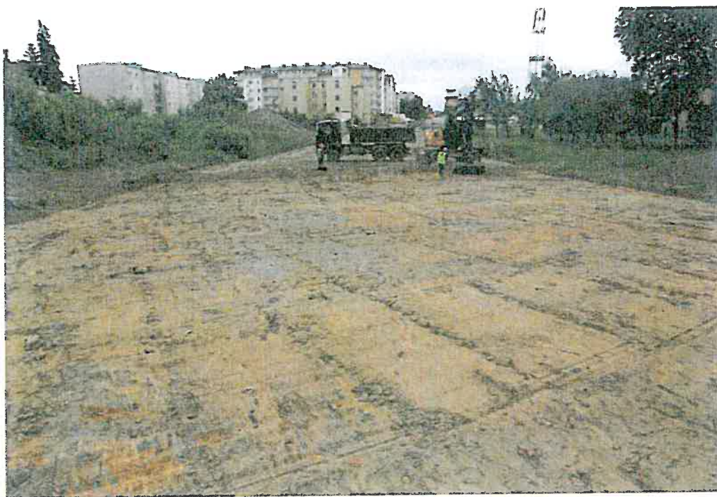
Fot. 1. Przebudowa ul. Warszawskiej oraz budowa i przebudowa ul. Modlińskiej na odcinku od ul. Paderewskiego do muru odgraniczającego teren zielony od parkingu przy budynku przy ul. Słowackiego 4 (dz. nr ew. 4/7 obr. 34-8-08) w 2015 r. Nadzór archeologiczny - kontrola prowadzonych prac ziemnych. Wschodnia część nadzorowanego odcinka.
