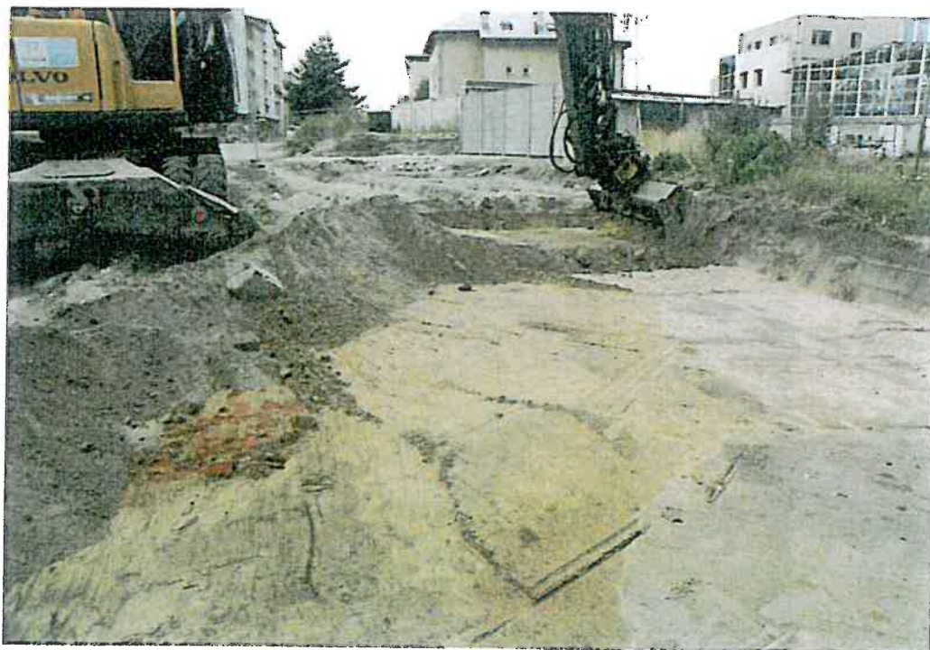
Fot. 16. Przebudowa ul. Warszawskiej oraz budowa i przebudowa ul. Modlińskiej na odcinku od ul. Paderewskiego do muru odgraniczającego teren zielony od parkingu przy budynku przy ul. Słowackiego 4 (dz. nr ew. 4/7 obr. 34-8-08) w 2015 r. Nadzór archeologiczny - kontrola prowadzonych prac ziemnych. Zachodnia część nadzorowanego odcinka.
