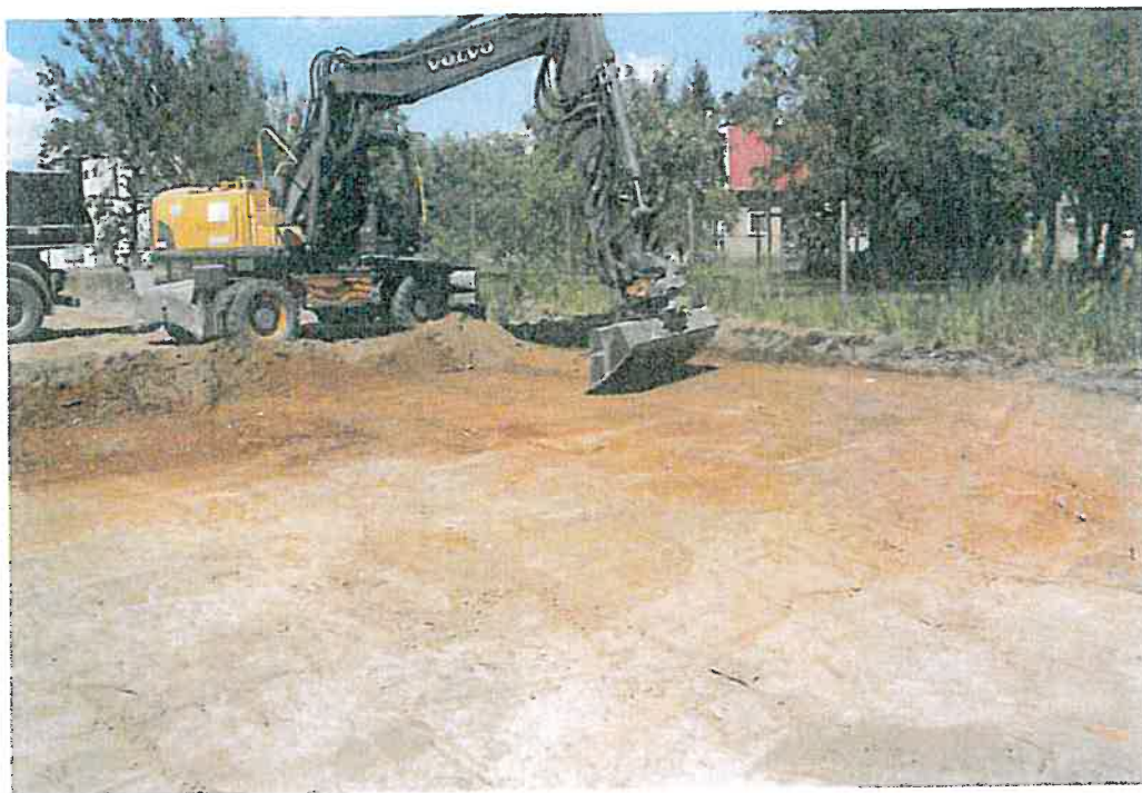
Fot. 9. Przebudowa ul. Warszawskiej oraz budowa i przebudowa ul. Modlińskiej na odcinku od ul. Paderewskiego do muru odgraniczającego teren zielony od parkingu przy budynku przy ul. Słowackiego 4 (dz. nr ew. 4/7 obr. 34-8-08) w 2015 r. Nadzór archeologiczny - kontrola prowadzonych prac ziemnych. Centralna część nadzorowanego odcinka.
