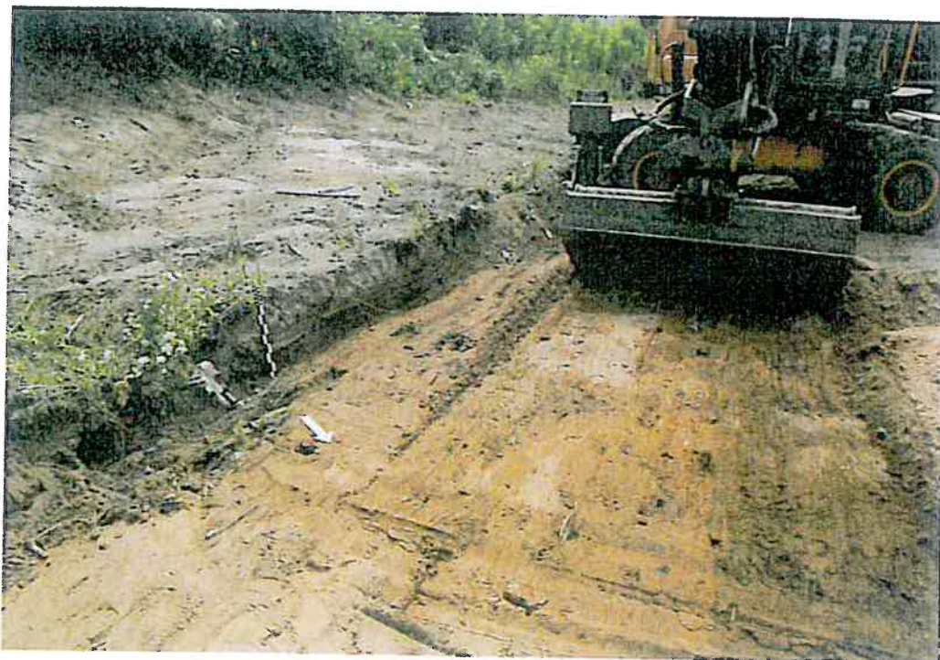
Fot. 7. Przebudowa ul. Warszawskiej oraz budowa i przebudowa ul. Modlińskiej na odcinku od ul. Paderewskiego do muru odgraniczającego teren zielony od parkingu przy budynku przy ul. Słowackiego 4 (dz. nr ew. 4/7 obr. 34-8-08) w 2015 r. Nadzór archeologiczny - kontrola prowadzonych prac ziemnych. Wschodnia część nadzorowanego odcinka.
