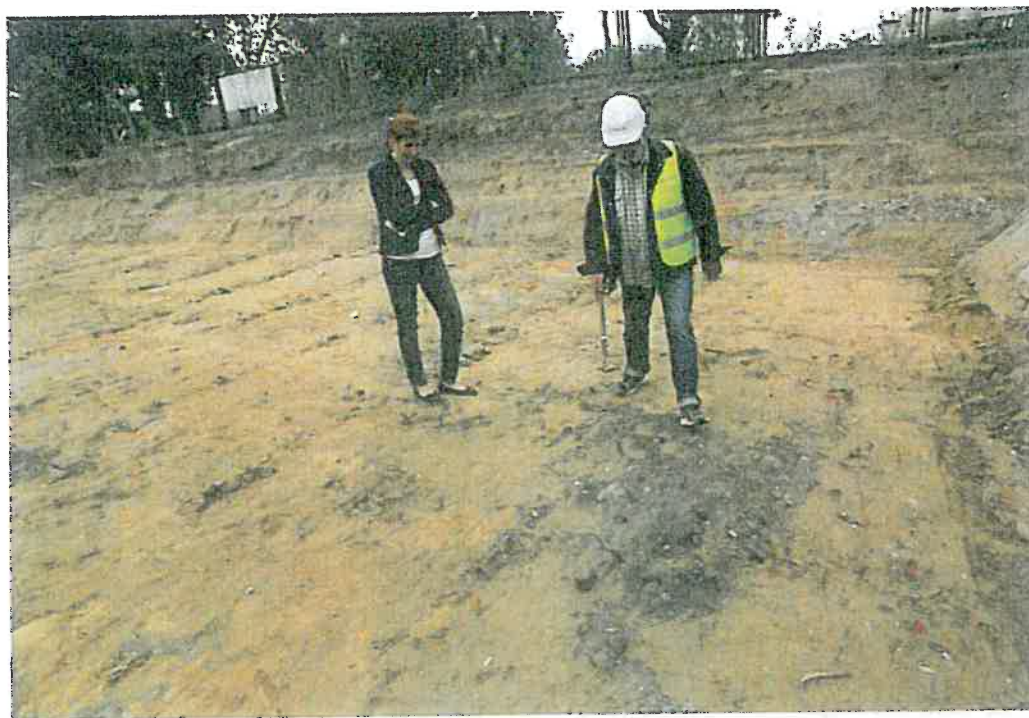
Fot. 2. Przebudowa ul. Warszawskiej oraz budowa i przebudowa ul. Modlińskiej na odcinku od ul. Paderewskiego do muru odgraniczającego teren zielony od parkingu przy budynku przy ul. Słowackiego 4 (dz. nr ew. 4/7 obr. 34-8-08) w 2015 r. Nadzór archeologiczny - kontrola prowadzonych prac ziemnych. Wschodnia część nadzorowanego odcinka. Wizyta Pani Naczelnik Wydziału Projektów Infrastrukturalnych w Nowym Dworze Mazowieckim.
