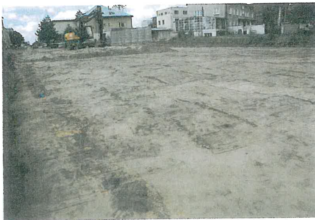
Fot. 10. Przebudowa ul. Warszawskiej oraz budowa i przebudowa ul. Modlińskiej na odcinku od ul. Paderewskiego do muru odgraniczającego teren zielony od parkingu przy budynku przy ul. Słowackiego 4 (dz. nr ew. 4/7 obr. 34-8-08) w 2015 r. Nadzór archeologiczny - kontrola prowadzonych prac ziemnych. Zachodnia część nadzorowanego odcinka.
