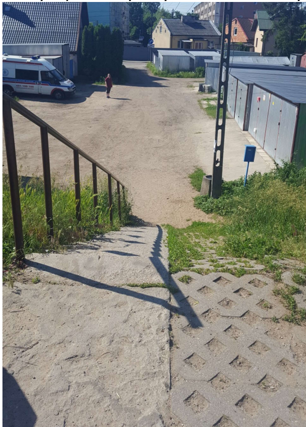
Fotografia 17. Schody do przebudowy na wysokości WOPR od strony odpowietrznej
