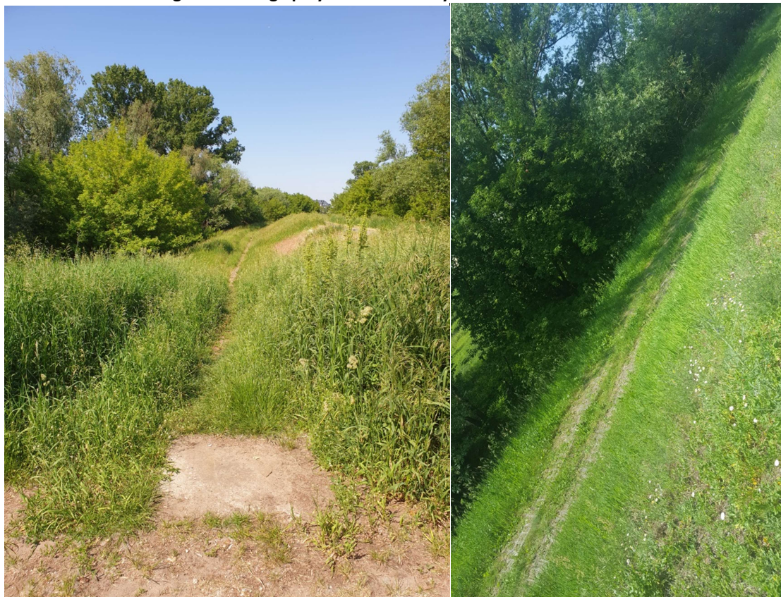
Fotografia 5. Droga przywałowa do oczyszczenia i odchwaszczenia
