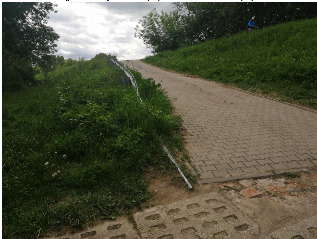
Fotografia 7. Przejazd z kostki przy CH HIT w km 0+300 – międzywale
