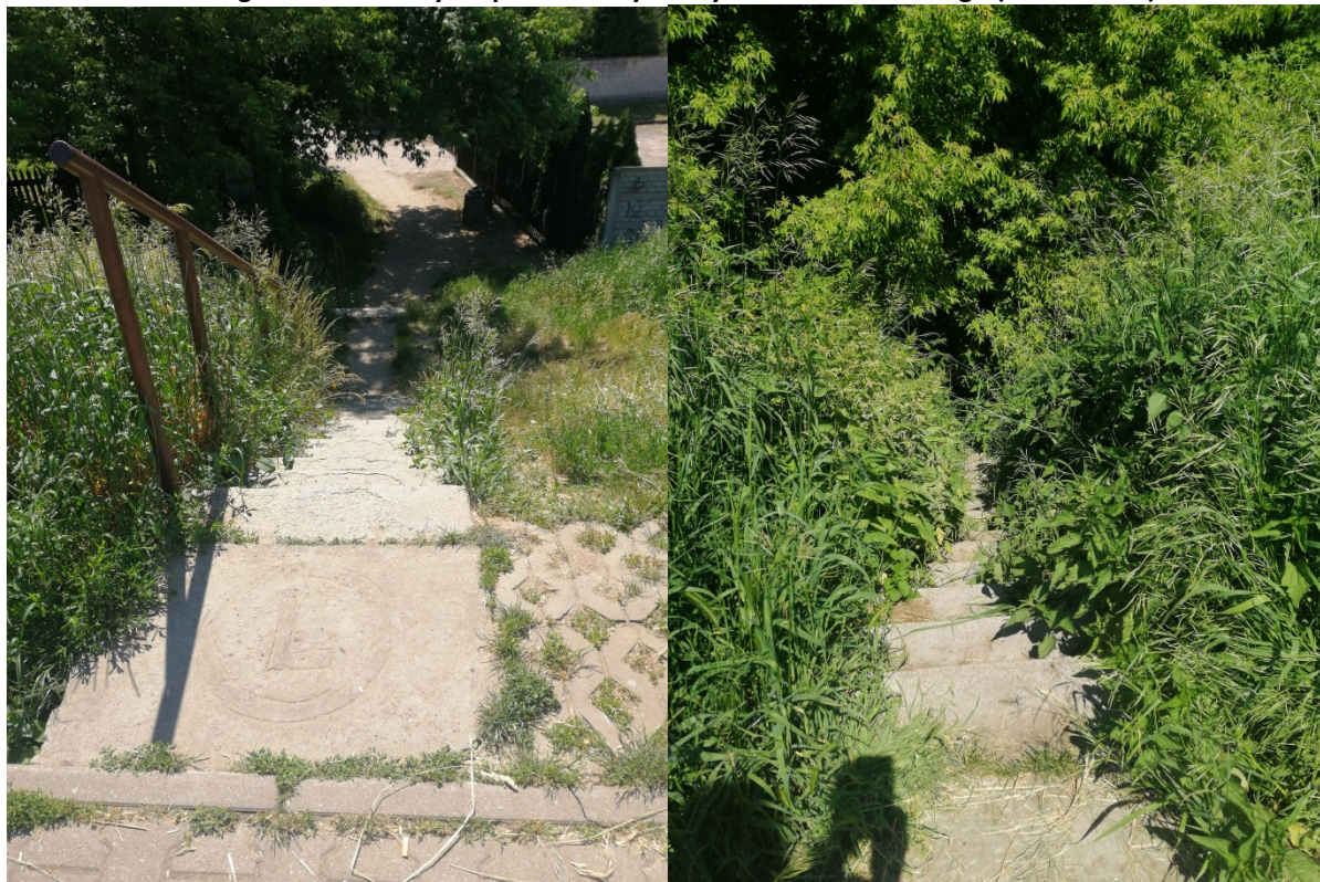
Fotografia 19. Schody do przebudowy na wysokości Placu Solnego (obustronne)
