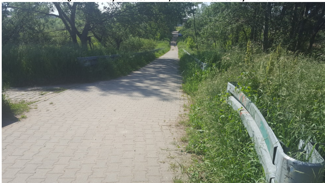
Fotografia 14. Przejazd z kostki na wysokości ul. Nadrzecznej – zawale
