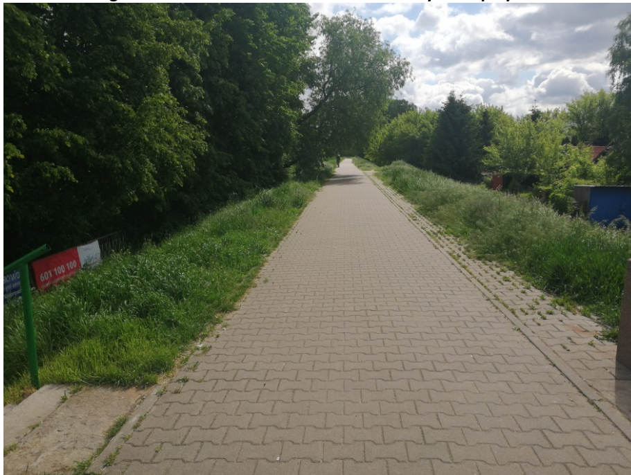
Fotografia 15. Poszerzenie utwardzenia korony wału przy WOPR
