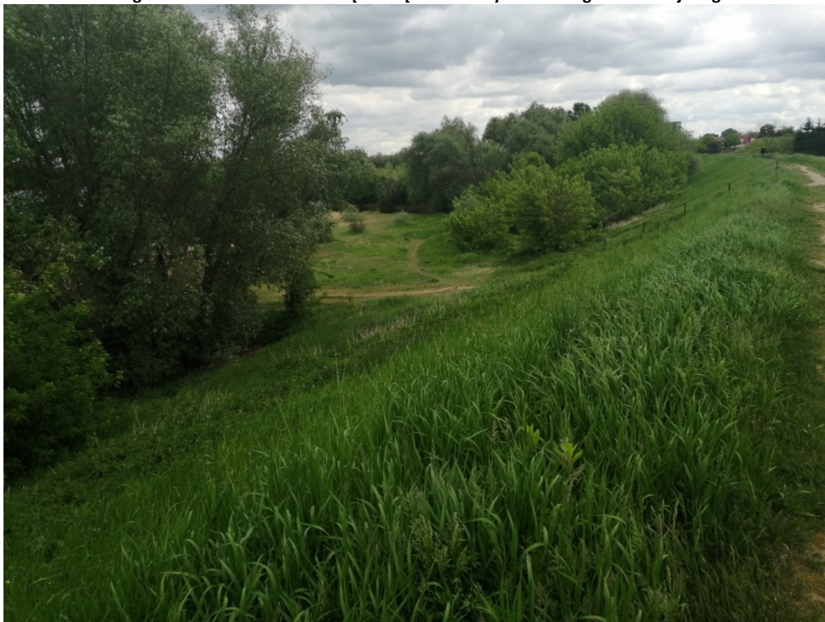
Fotografia 25. Widok na odwodną stronę wału na wysokości targowiska miejskiego.
