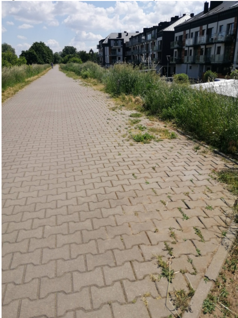
Fotografia 16. Poszerzenie utwardzenia korony wału w km 1+535 – 1+586
