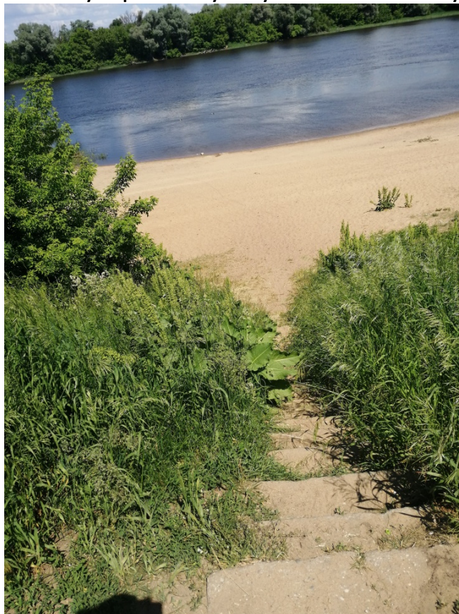
Fotografia 18. Schody do przebudowy na wysokości WOPR od strony odwodnej
