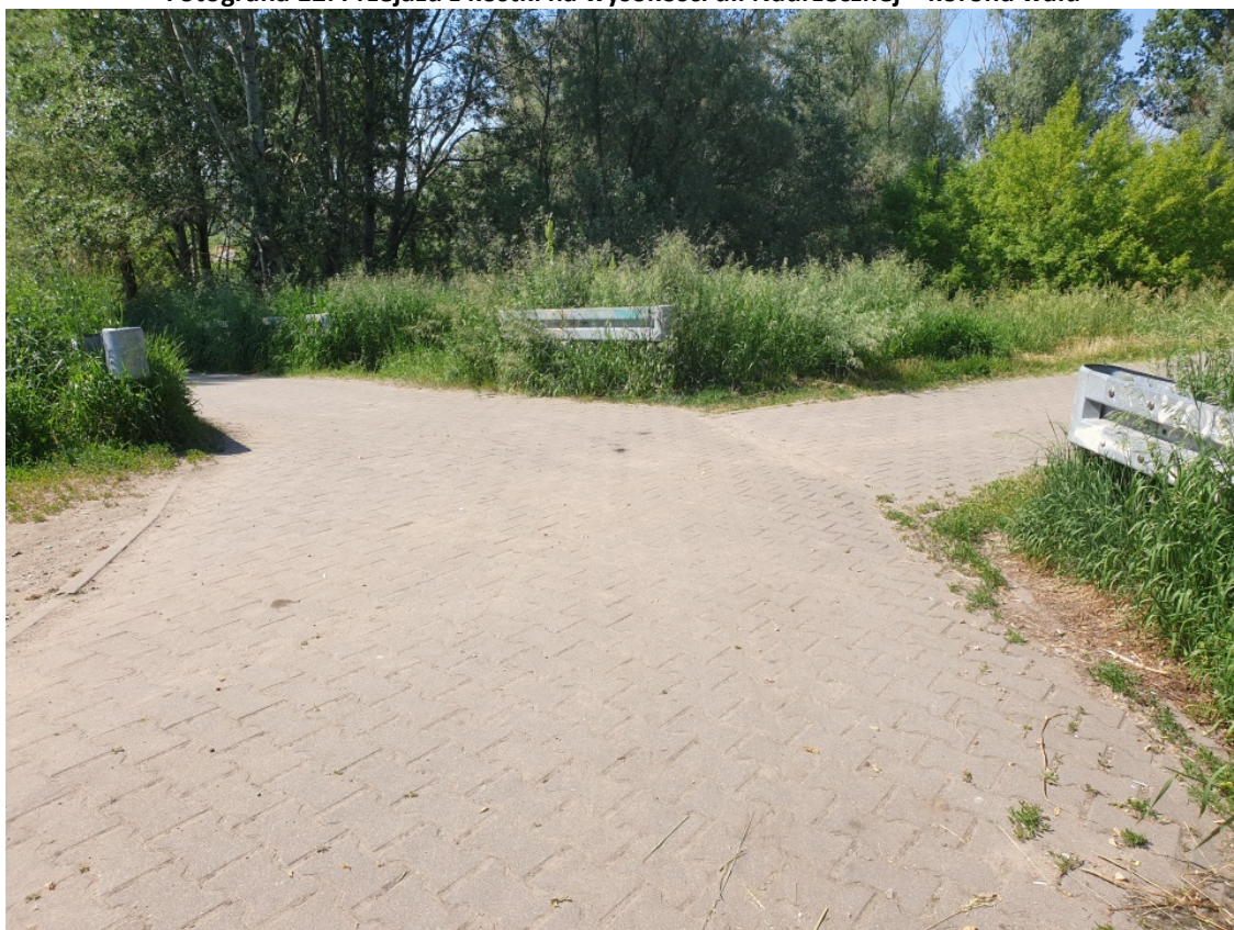
Fotografia 12. Przejazd z kostki na wysokości ul. Nadzecznej – korona wału
