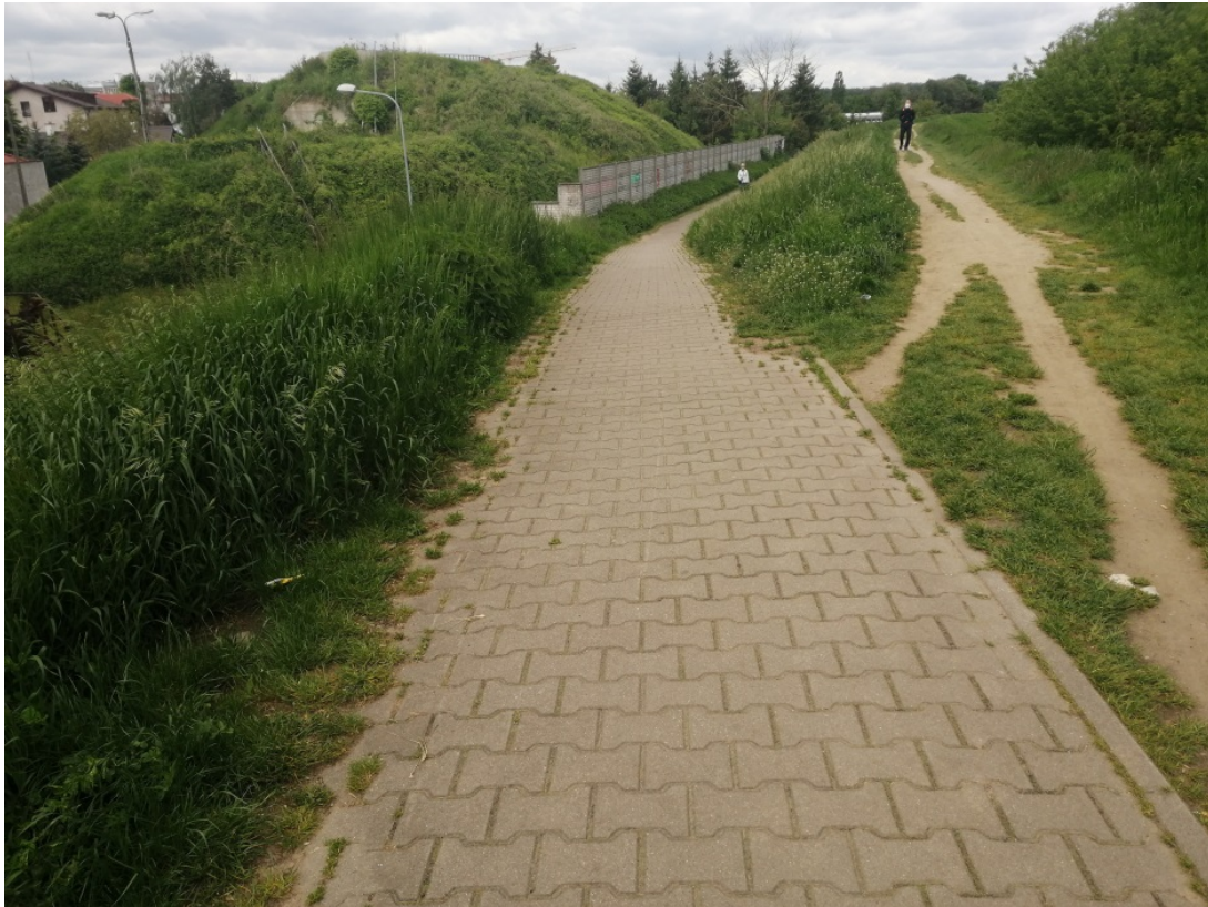
Fotografia 3. Koniec umocnienia korony wału, początek drogi przywałowej w km 1+107
