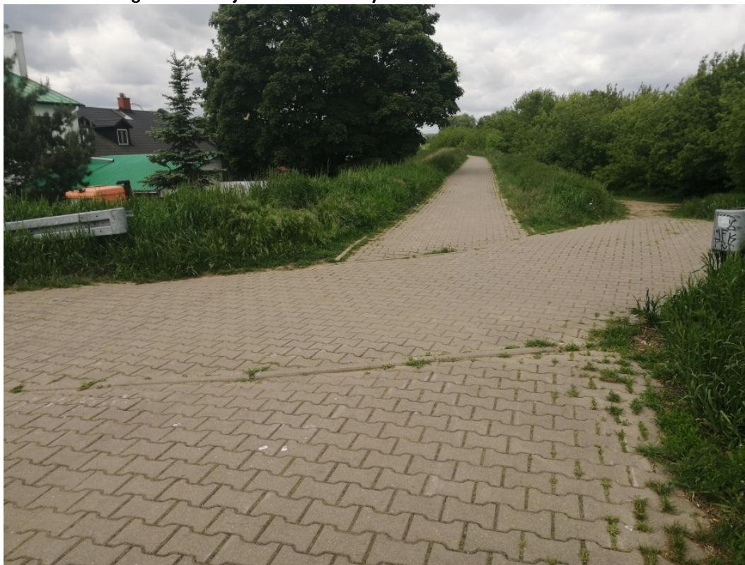
Fotografia 9. Przejazd z kostki na wysokości ul. Kościuszki – korona wału
