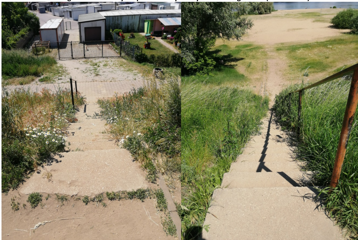
Fotografia 20. Schody do przebudowy na wysokości targowiska (obustronne)
