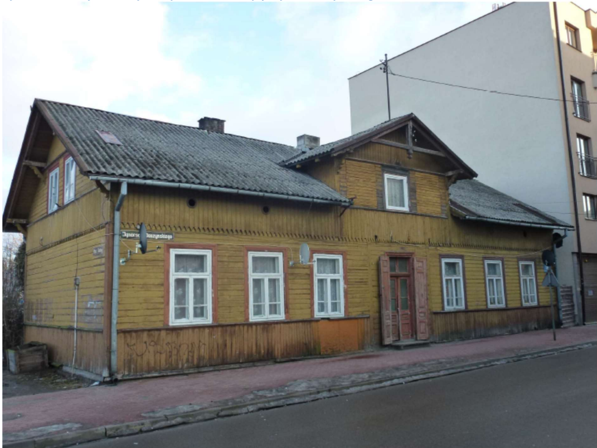
Rysunek 6. Budynek zabytkowy zlokalizowany przy ul. Daszyńskiego 18
