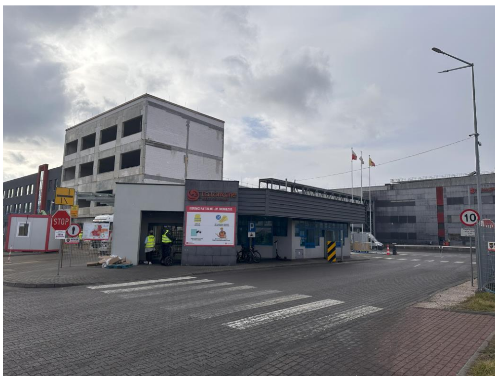
Fot.5 Wjazd do zakładu La Lorraine
