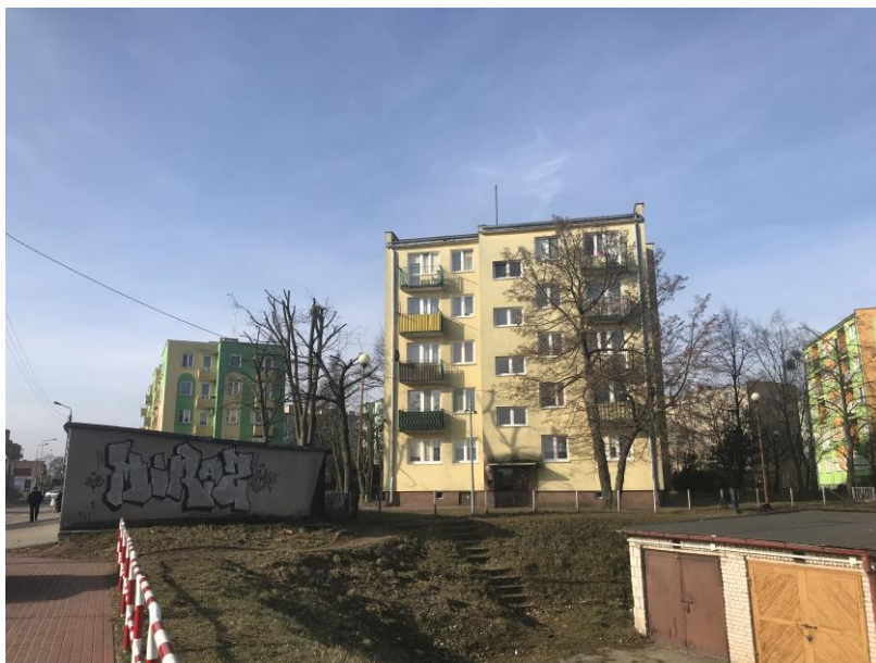
Fot.5. Tereny przyległe – zabudowa wielorodzinna i zgrupowanie garaży
