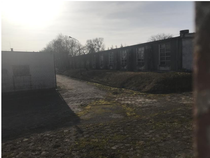
Fot. 1 Istniejąca zabudowa warsztatowa
