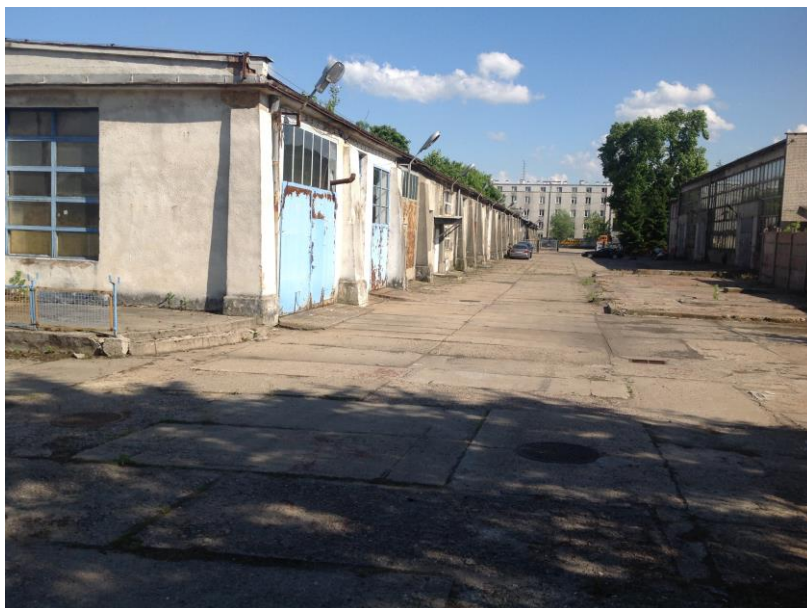
Fot. 6 Istniejący stan nawierzchni terenu opracowania.
