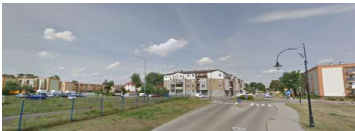
Fot. 2 Istniejąca zabudową mieszkaniową wielorodzinną w rejonie ulicy Sadowej
